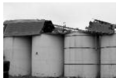
屋根が壊れたサイロ
