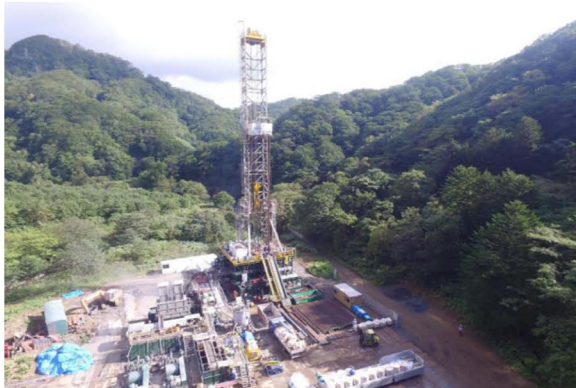
掘削調査の様子(鉛川地区)
